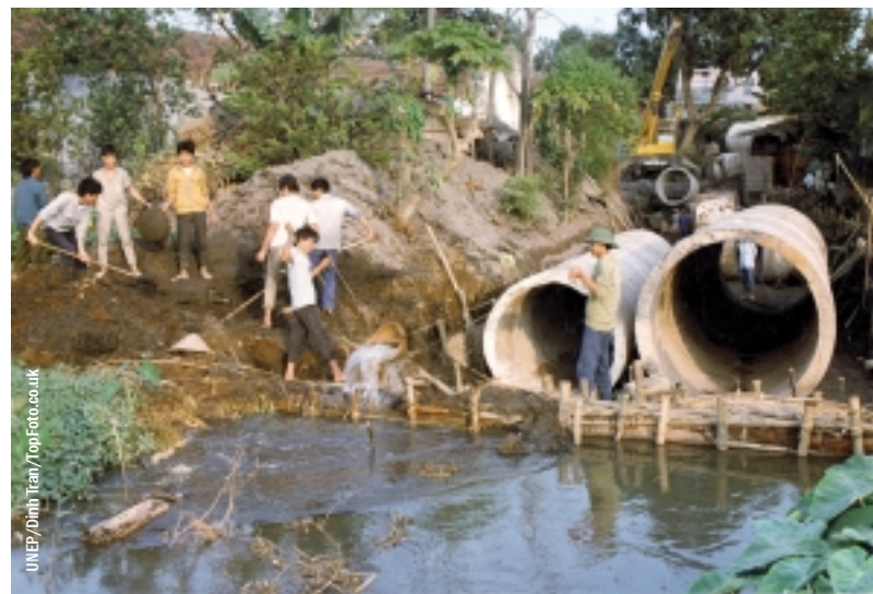
Mejoramiento de la infraestructura para el agua y el saneamiento en Vietnam.
